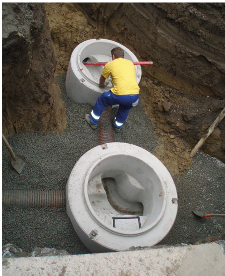
Záběry z výstavby kanalizačního řádu.
