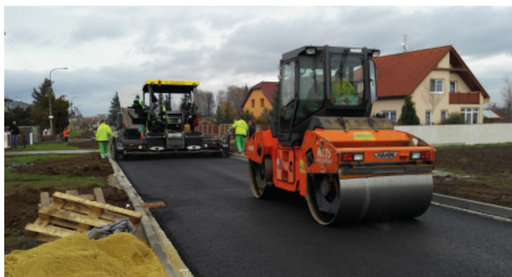
Rekonstrukce ulice směrem na Slatinice, pokládka asfaltu.
