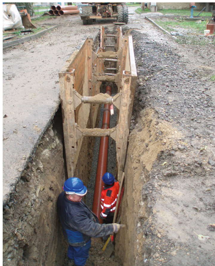
Záběry z výstavby kanalizačního řádu.
