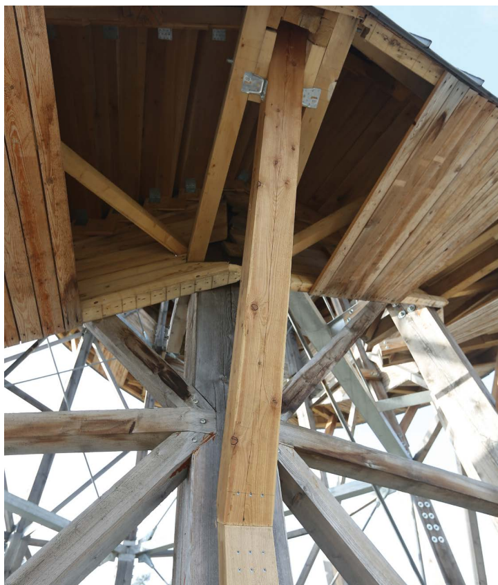
Nově doplněné podpěry schodiště, které jej posílí a stabilizují.
