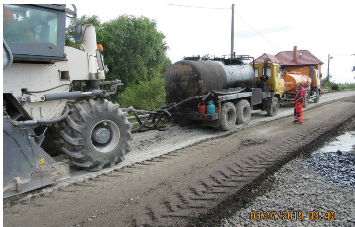
Rekonstrukce silnice z Luběnic do Rataj
