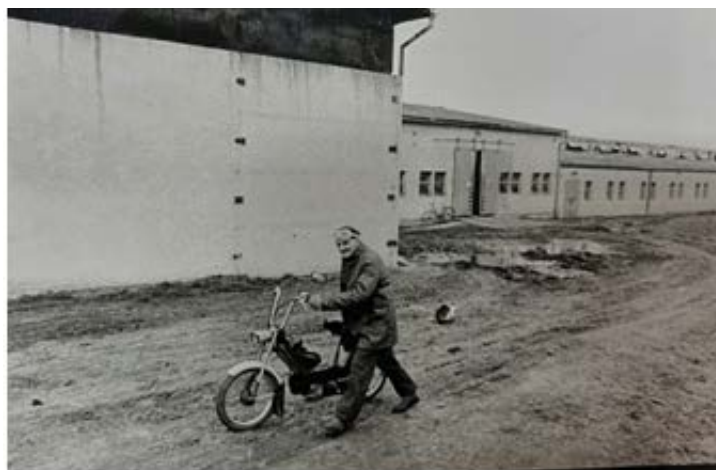
Budovy nového kravína
